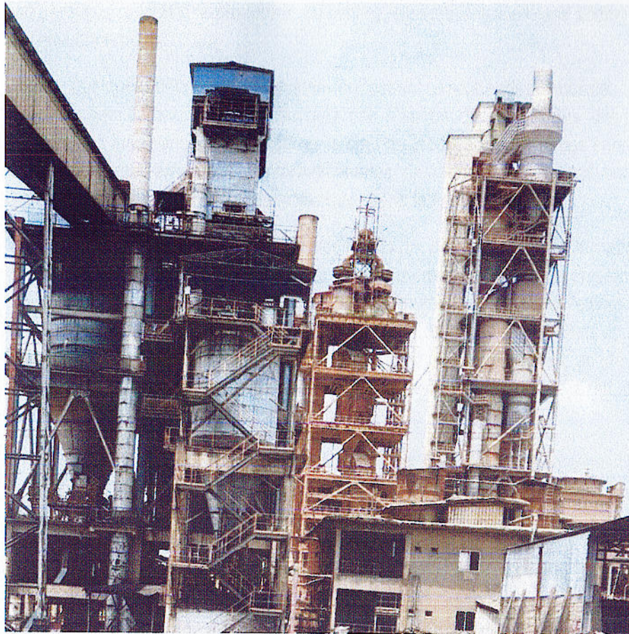
Figure 6 : Nouvelle unité avec un nouveau four avec précalcinateur
